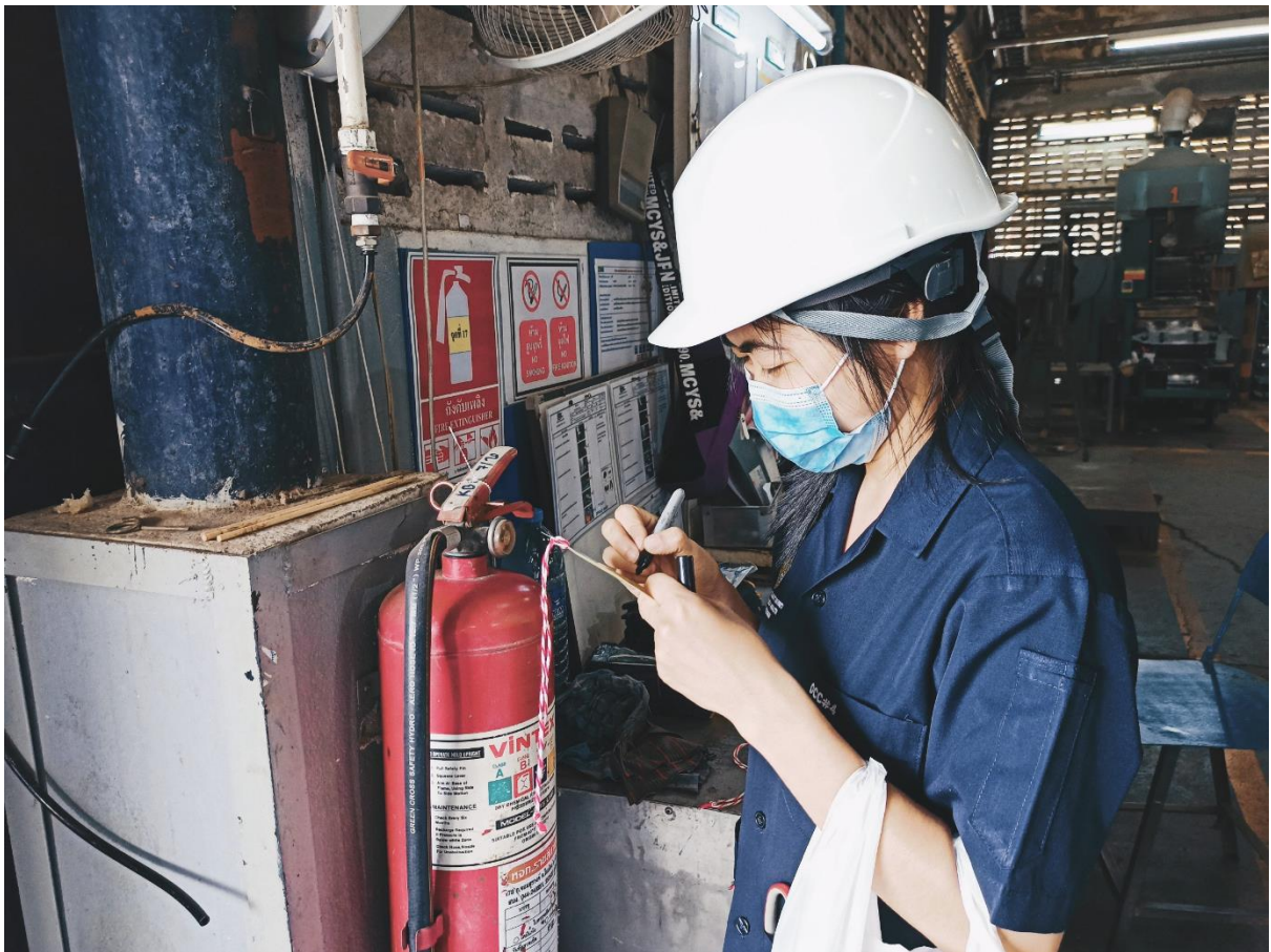
ภาพที่ 4 ภาพกิจกรรมการตรวจเช็คถังดับเพลิง
