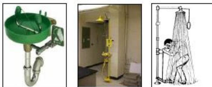
รูป 12 อ่างล้างตาและที่ล้างตัวฉุกเฉิน
