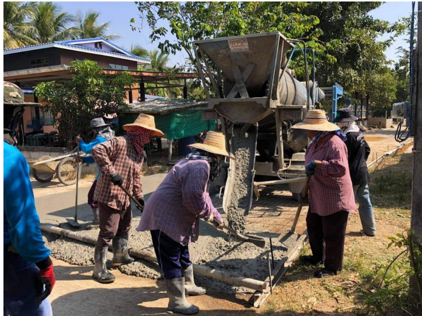
ภาพที่ 3.9 เทคอนกรีต
