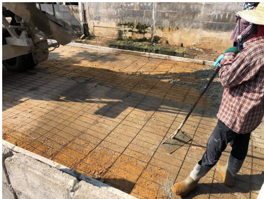
ภาพที่ 3.5 วางเหล็กตะแกรง
