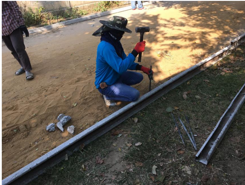
ภาพที่ 3.4 ติดตั้งแบบเหล็ก
