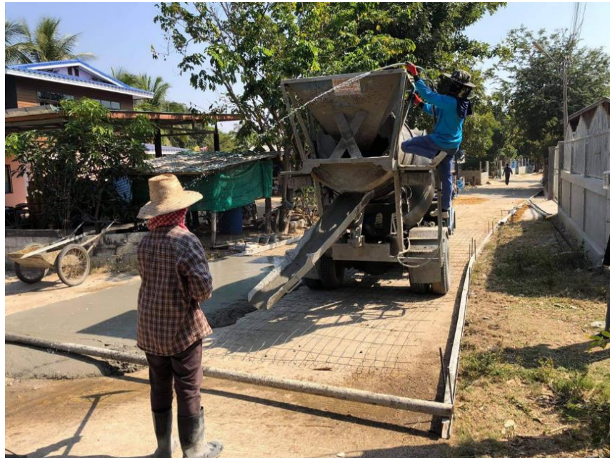
ภาพที่ 3.6 รดน้ำก่อนเทคอนกรีต
