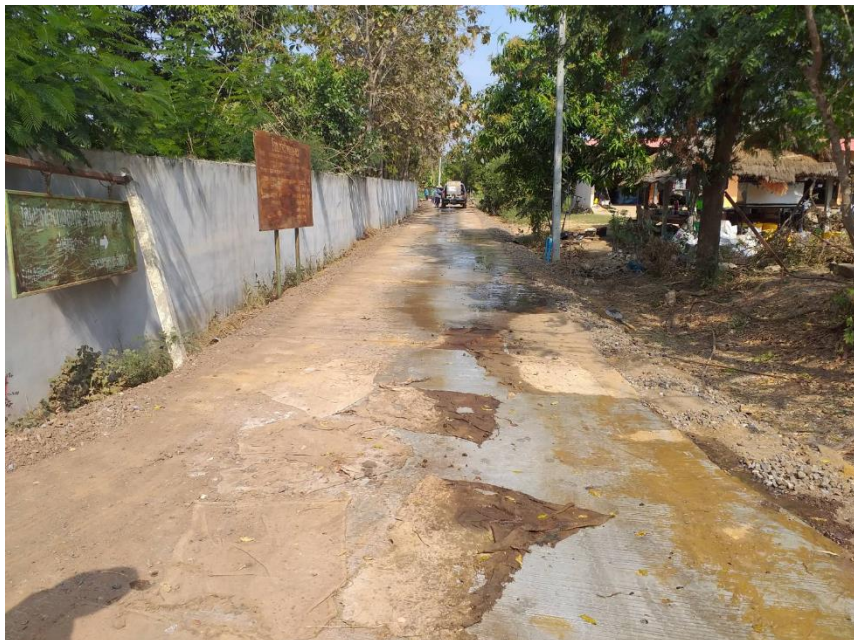
ภาพที่ 3.13 บ่มคอนกรีต
