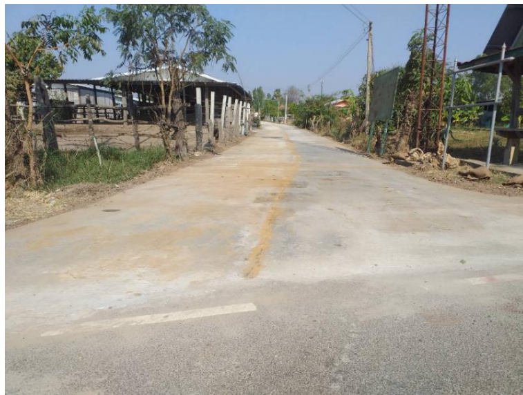
ภาพที่ 4.6 หลังสร้างเสร็จ
