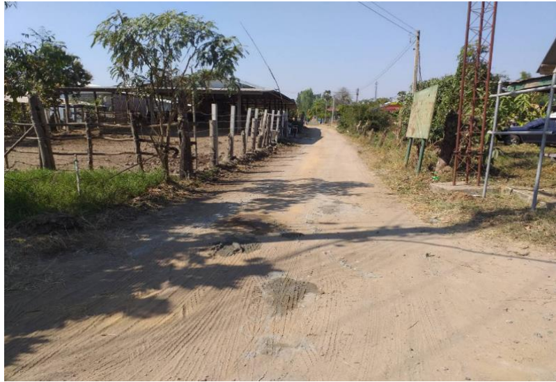
ภาพที่ 4.5 ก่อนก่อสร้าง
