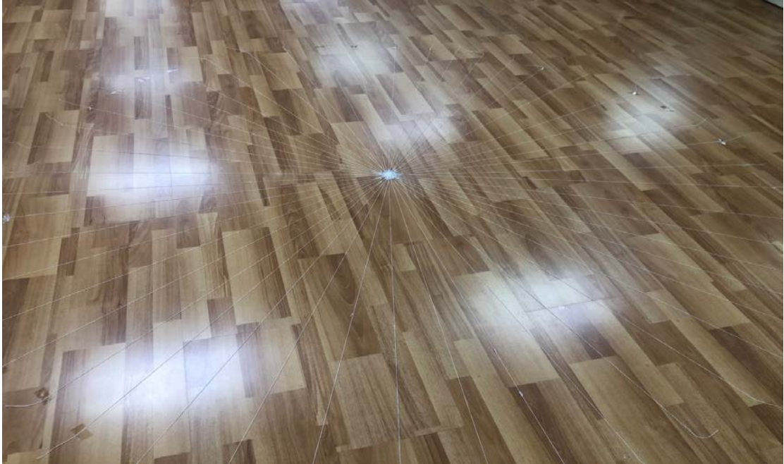
ภาพ 4.6 การตีเส้นที่เสร็จสมบูรณ์
