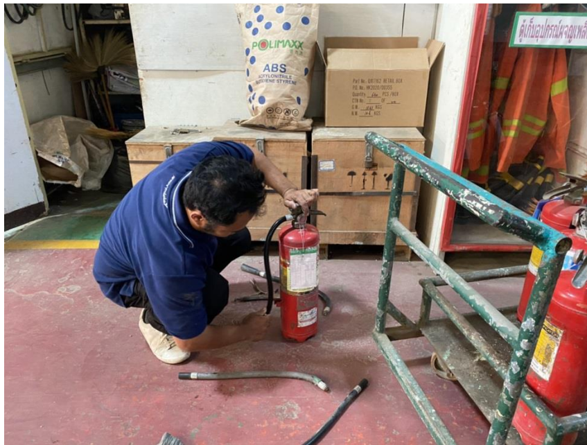
เปลี่ยนสายถังดับเพลิง
