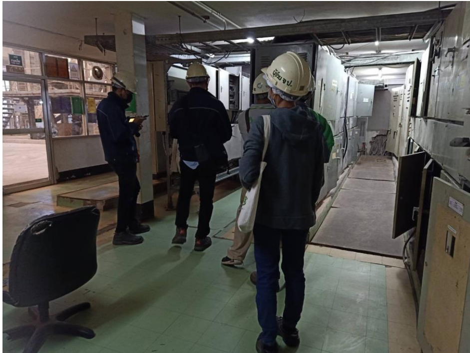
ภาพการติดตามการตรวจรับรองไฟฟ้าประจำปี
