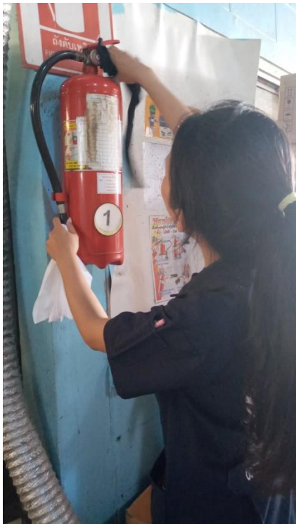
การตรวจเช็ค การทำความสะอาดถังดับเพลิง และสัญญาณแจ้งเหตุเพลิงไหม้
