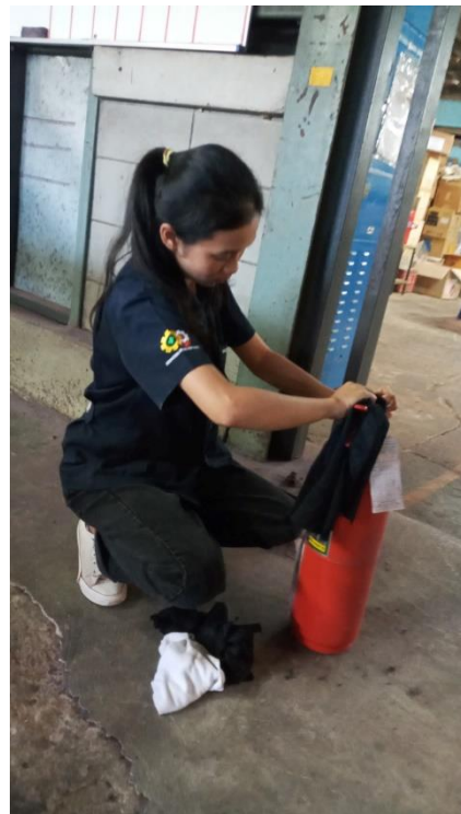
การตรวจเช็ค การทำความสะอาดถังดับเพลิง และสัญญาณแจ้งเหตุเพลิงไหม้
