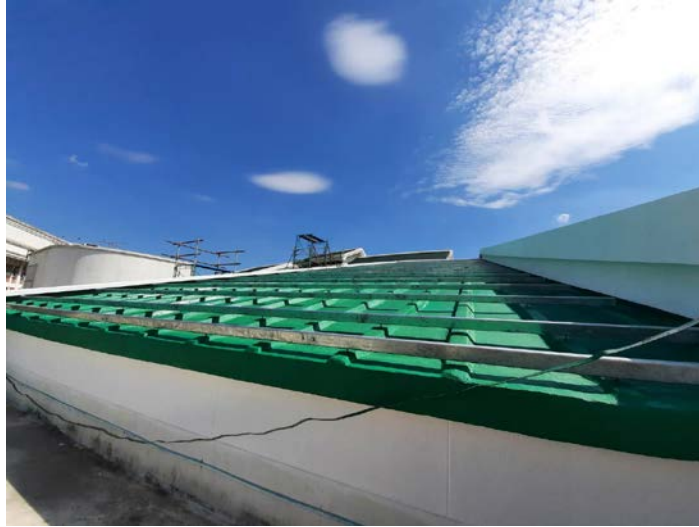
ภาพที่ 3.2 วางเหล็กกล่องเพื่อยึดหลังคา
