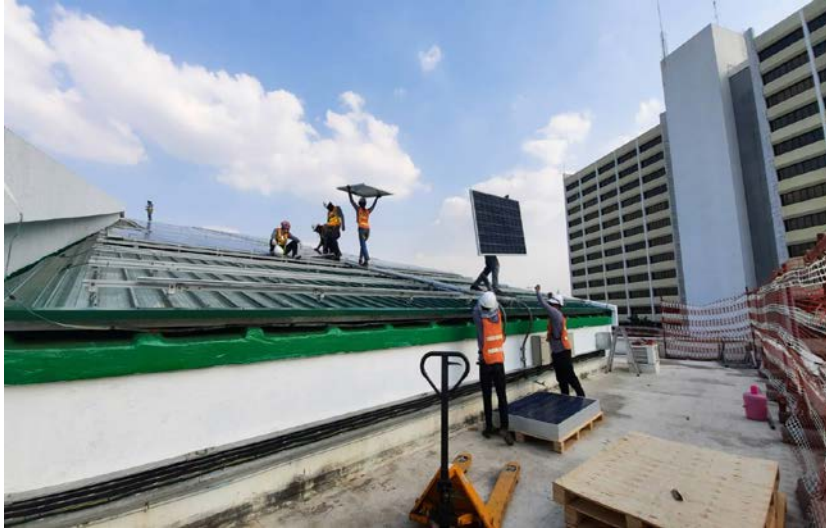
ภาพที่ 3.4 การติดตั้งแผงเซลล์แสงอาทิตย์
