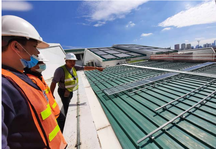
ภาพที่ 3.3 การติดตั้งหลังคาเมทัลชีทและติดตั้งรางอลูมิเนียม
