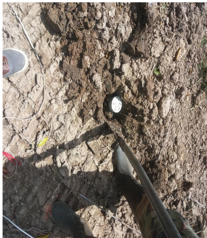
ภาพที่ 4.6 การปักหลักเขตที่ดิน
