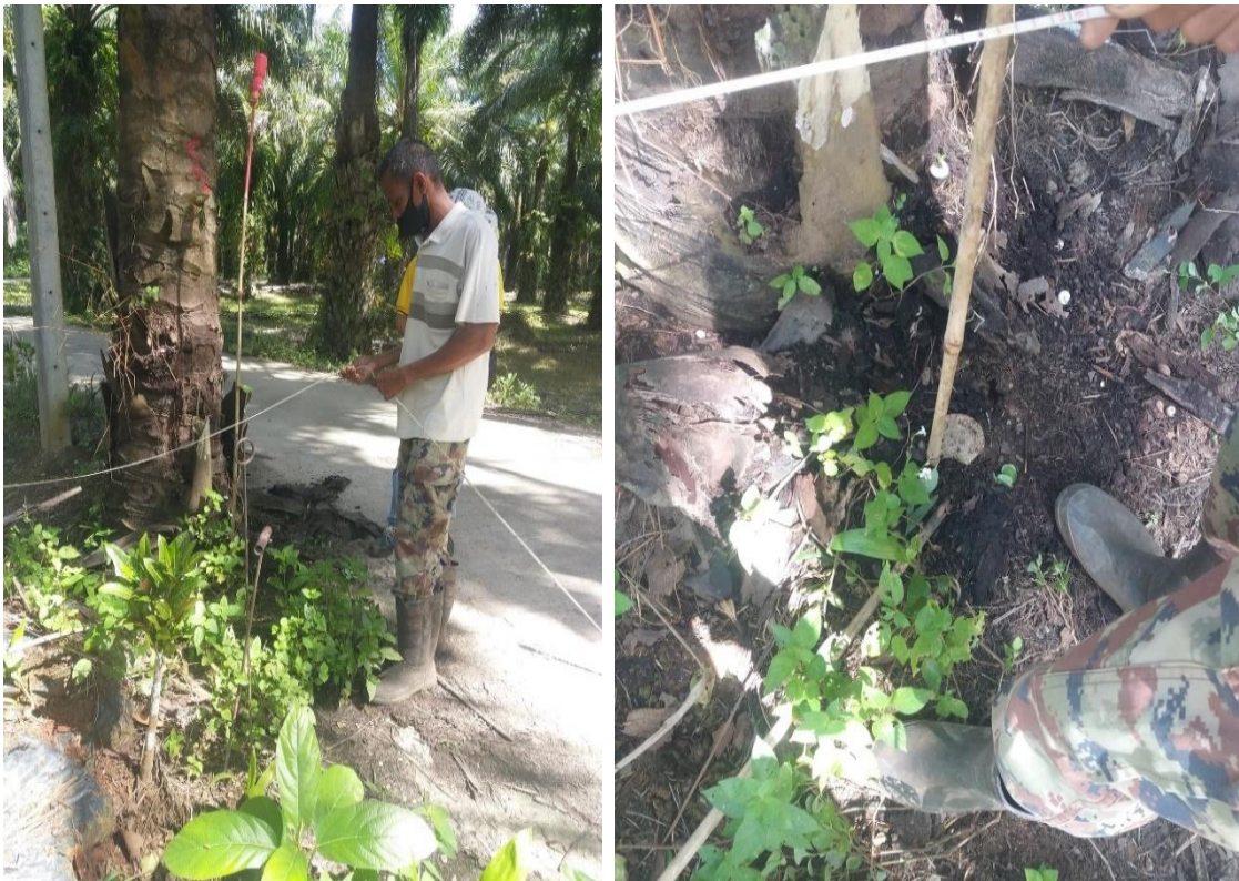
ภาพที่ 4.3 การหาแนวเขต หลักเขตที่ดิน โดยการตรวจสอบด้วยเทปวัดระยะ
