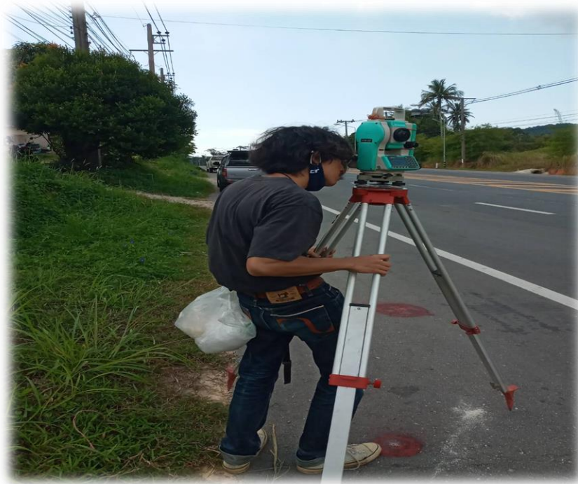
ภาพที่ 4.10 ระหว่างการปฏิบัติงานรังวัดโดยใช้กล้อง Total Station
