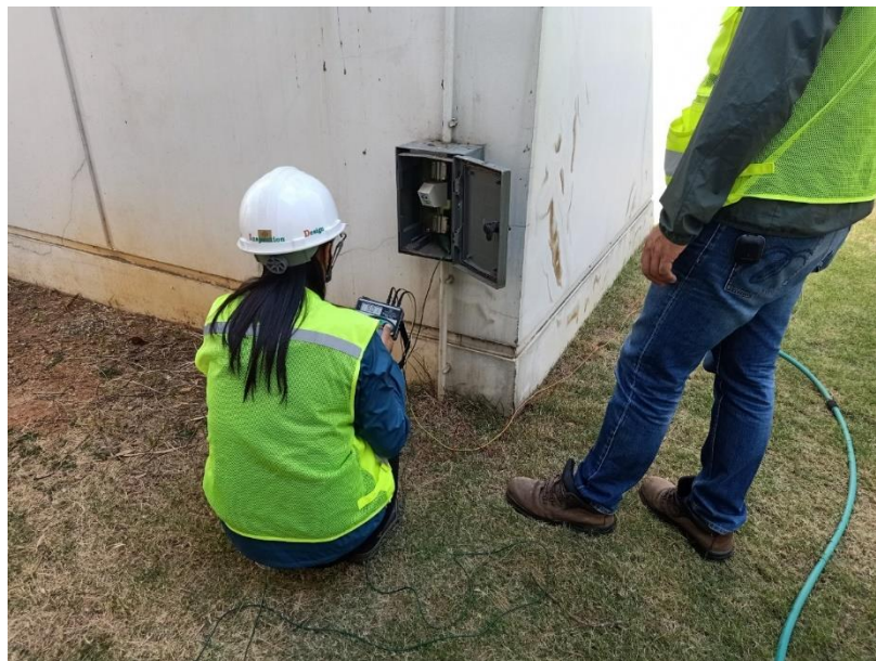
ตรวจสอบอาคารและระบบไฟฟ้าประจำปี
