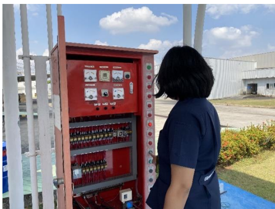
ภาพที่ 1-12 เดินเครื่องทดสอบระบบปั้มน้ำดับเพลิง
