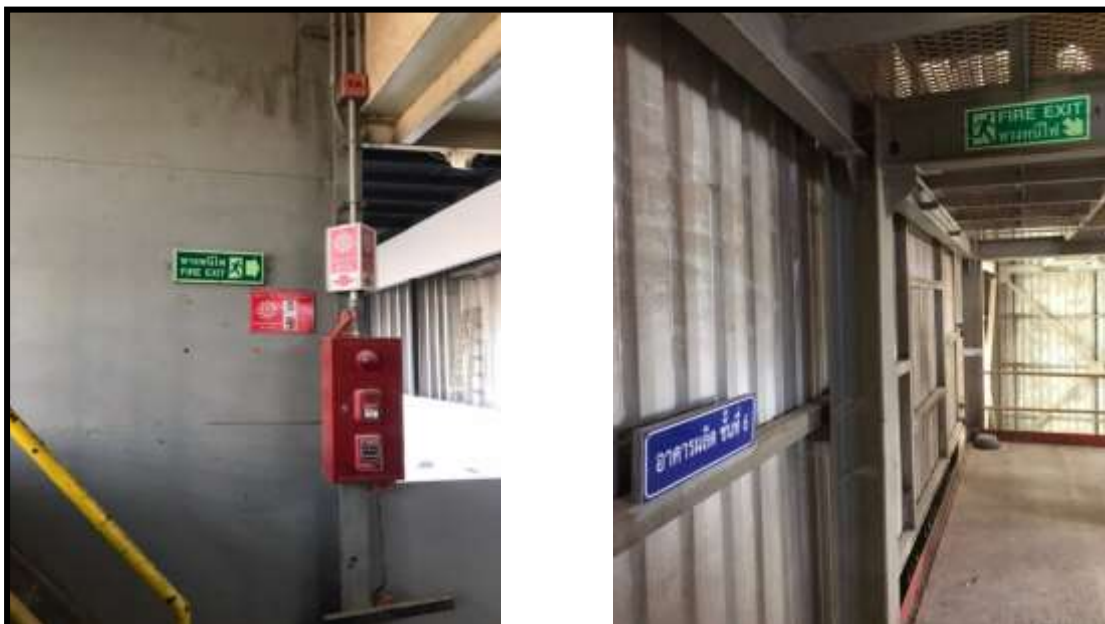
เดินสำรวจเส้นทางหนีไฟ
