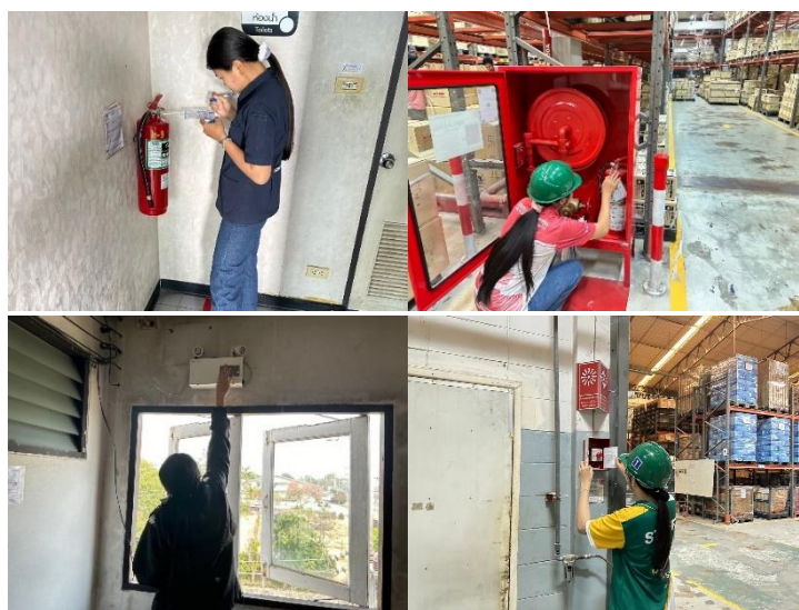
ภาพที่ 1.8 ตรวจถังดับเพลิงภายในโรงงาน
