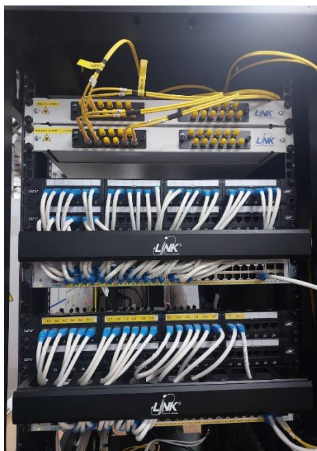
ภาพ:การปฏิบัติงานติดตั้งตู้ Server ของ line 4
