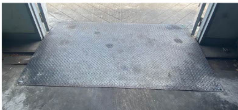
ภาพที่ 16 การติดตั้งทางลาดเอียงสำหรับรถเข็นสารเคมี
