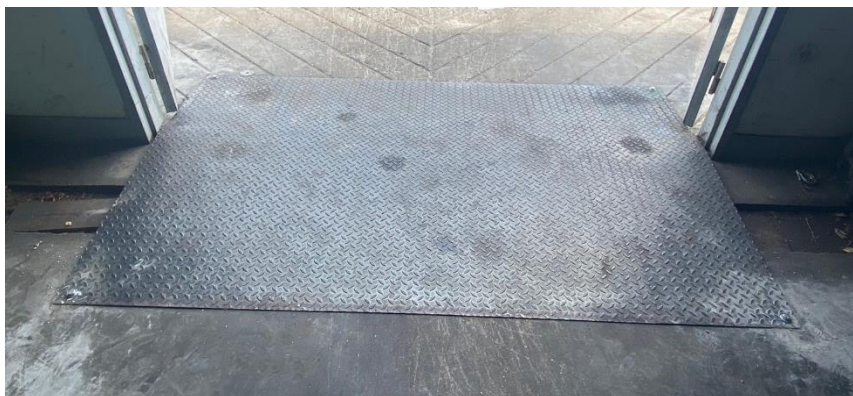
ภาพที่ 16 การติดตั้งทางลาดเอียงสำหรับรถเข็นสารเคมี
