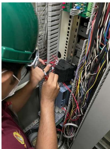
รูป 4.6.4 ต่อดังต่อไปนี้จาก 2mcb ไปยัง เทอร์มินอลไฟฟ้า
