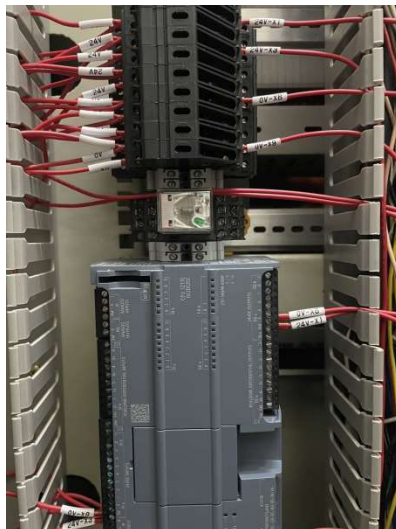
รูป 4.6.5 ต่อวงจรจากเทอร์มินอลฟิวส์ไปยังจุดรับไฟเลี้ยงของ CPU
