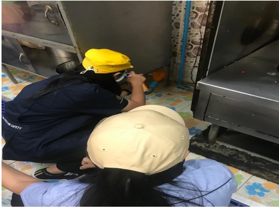
ตรวจสอบ Gas Detector 1 ครั้ง/เดือน
