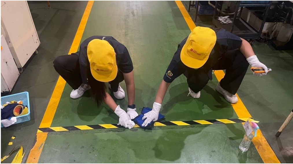
ติดเส้นเหลืองดำที่บริเวณทางเดินระหว่างไลน์ 3FO และ3EO
